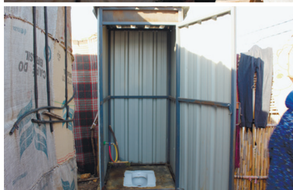
日赤の設置した水タンクは1000リットルの貯水ができる(写真上)。穴を掘って囲いを付けたトイレが設置された(写真下)
